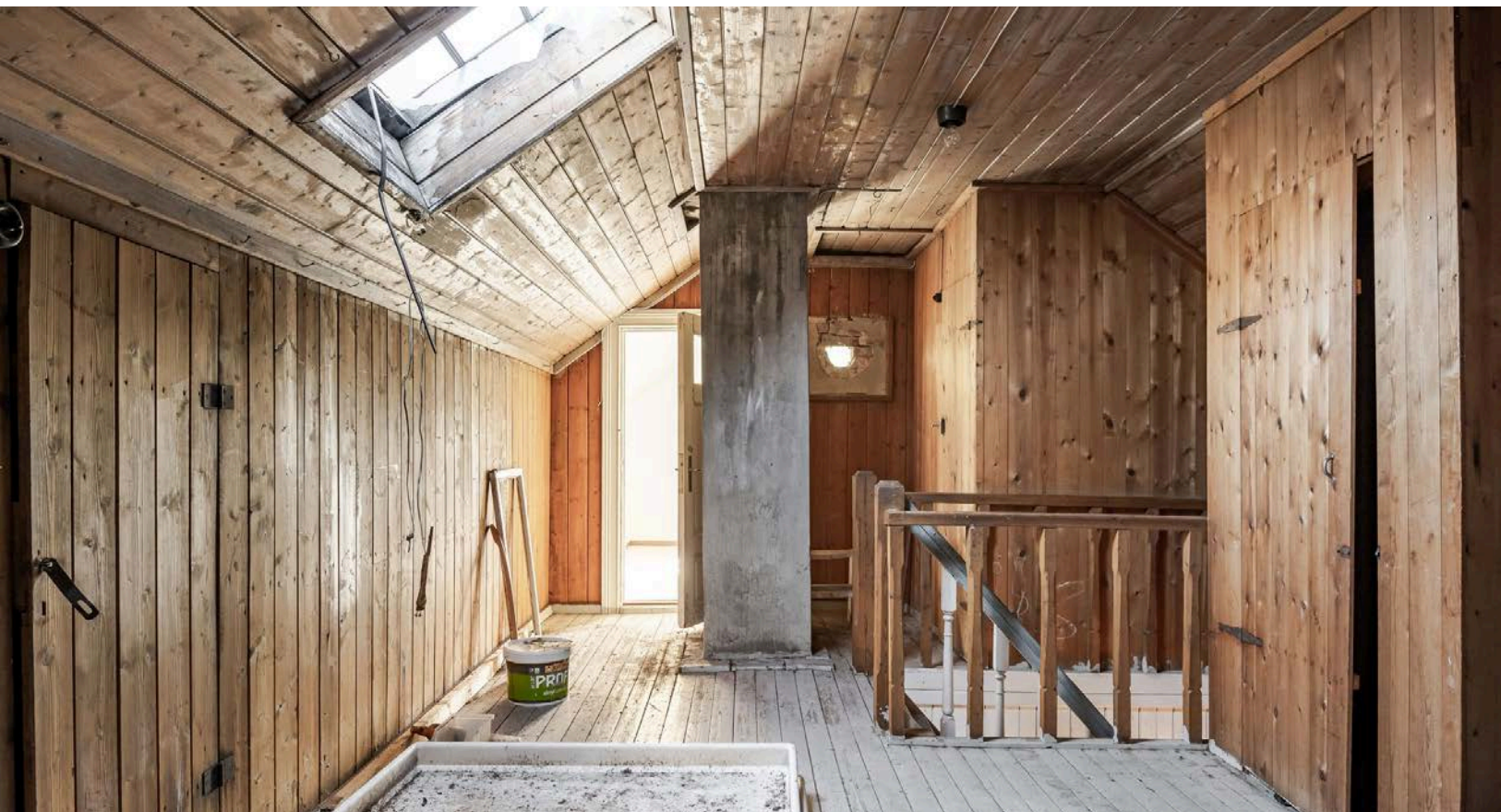
Gang/trapperom i 2. etasje.
