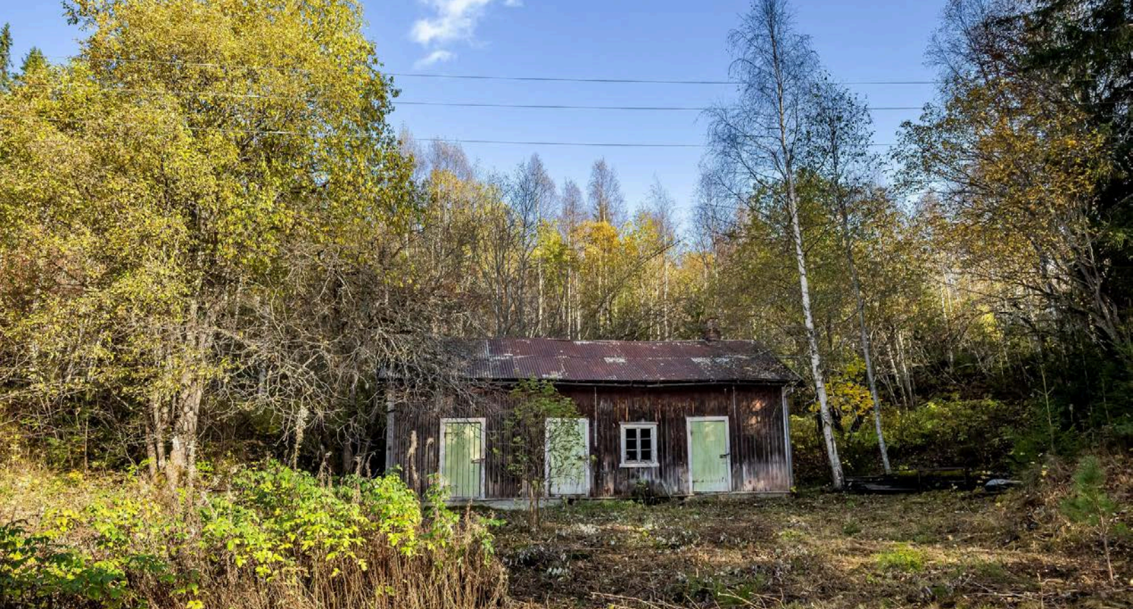
Uthus med bruksareal på ca. 70m 2 fordelt på 2. etasjer. Bygget har gjennomgående lav standard. Generelt med preg av skader, aldersforvitring og manglende vedlikehold.
