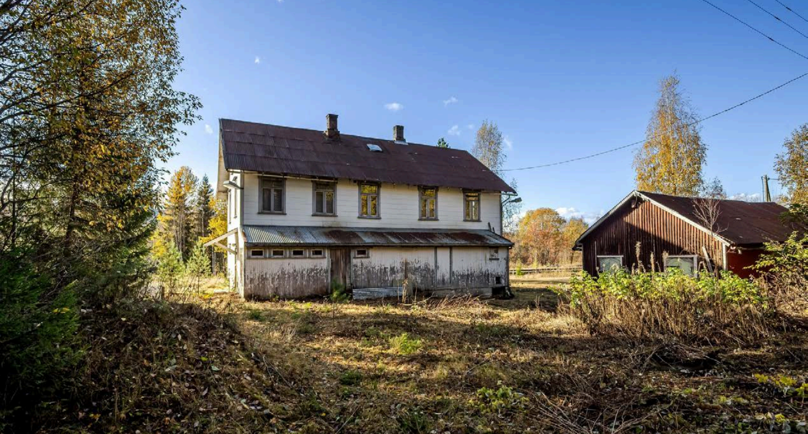
Boligyttervegger i bindingsverk, antatt isolert med flis. Yttervegg kledd med eternittplater. Delvis med stående panel. Takflatene er tekket med bølgeblikkplater.
