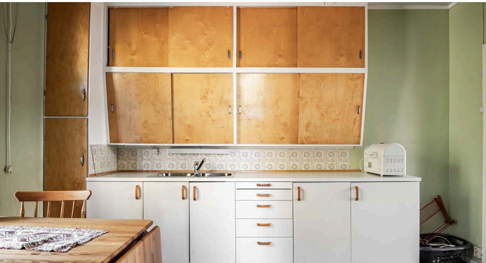
Eldre kjøkkeninnredning med glatte fronter, laminert benkeplate med nedfelt oppvaskkum og vinylbelegg i benkeryggen. Montert håndvask på vegg.
