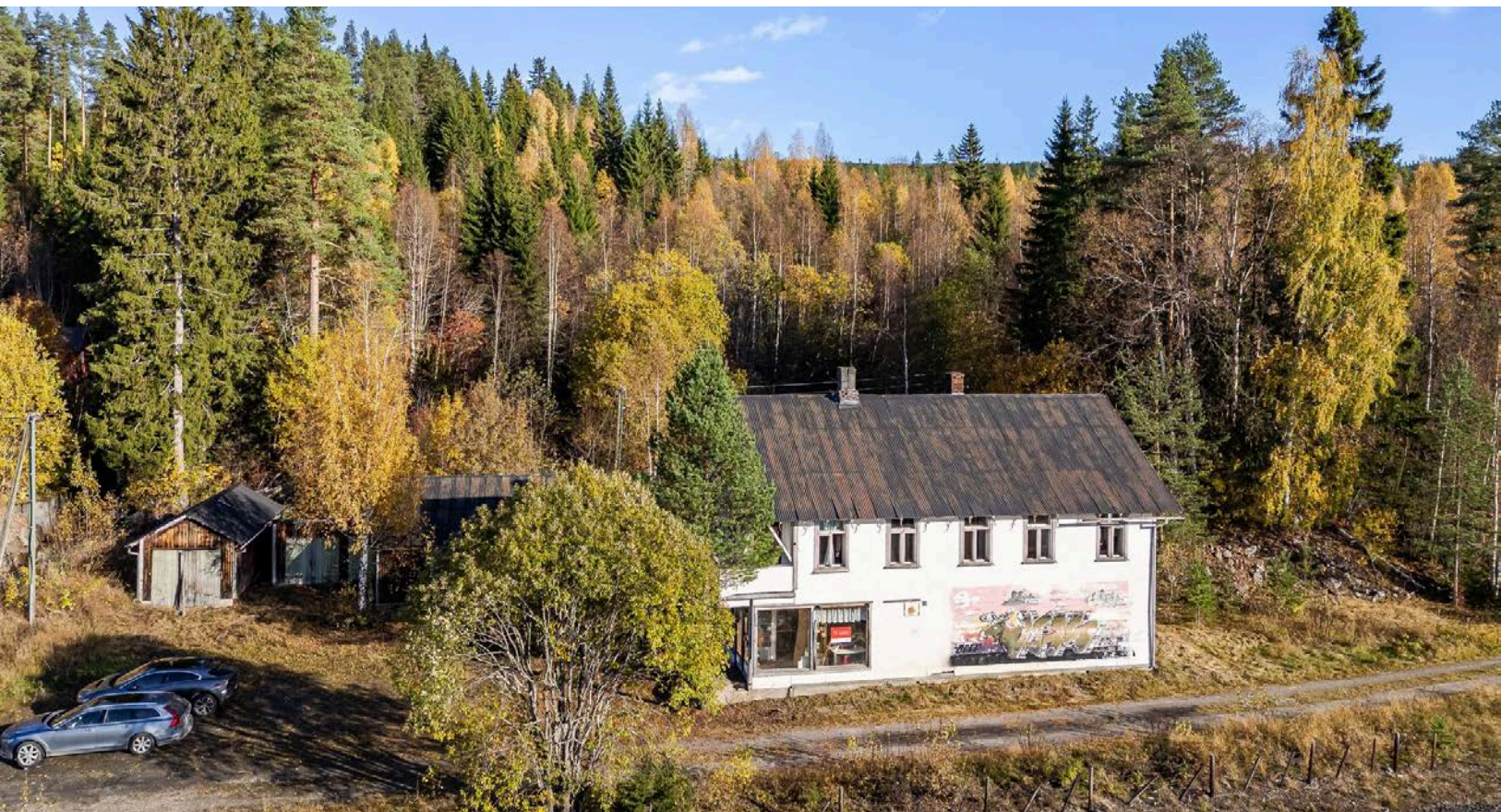
Eiendommen er også bebygd med eldre bygninger som 2 uthus, utedo, traktorgarasje og bakestue, samt et laftet bygg i dårlig forfatning.
