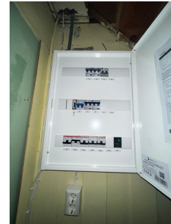
Sikringskapp i trappenedgang i 1. etasje
