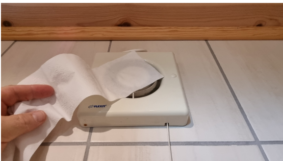
Funksjonstesting av det mekaniske avtrekket i ytterveggen.
