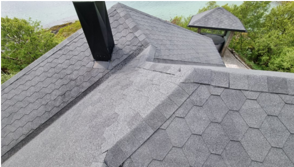
Visuell besiktelse av taket.
