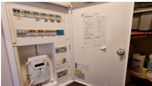
Kontroll av el-skapet
