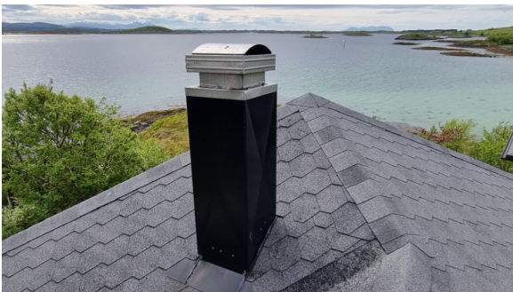
Kontroll av pipebeslag.
