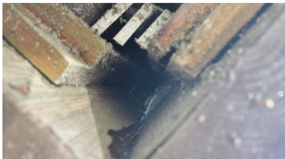
Kontroll av tetting bak ytterkledningen.
