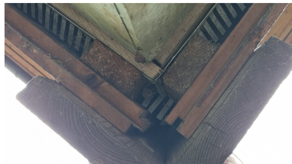
Kontroll av tetting bak ytterkledningen
