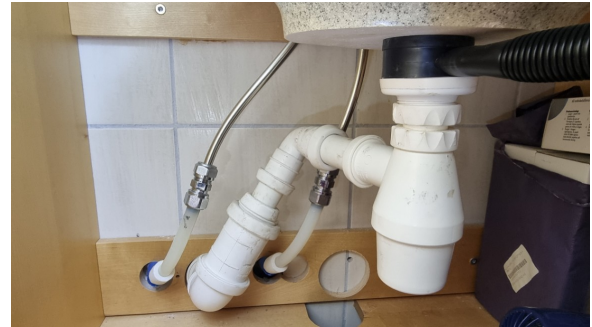
Kontroll av røropplegg under servanten.
