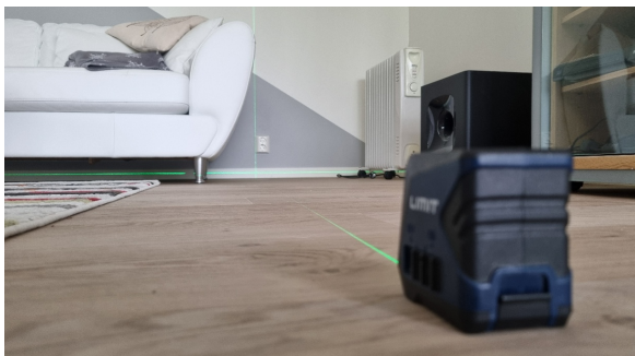
Måling av eventuelle planavvik med krysslaser. Her vist fra stue hvor største målte planavvik innenfor en diameter av 2 meter var kun ca. 1 mm, og største målte planavvik i hele rommet var kun ca. 2 mm.
