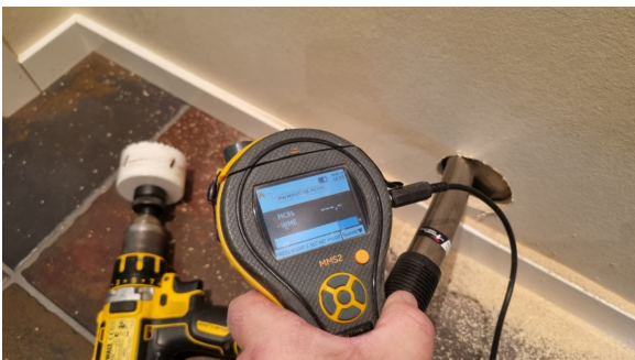
Hulltaking utført fra tilstøtende gang.
