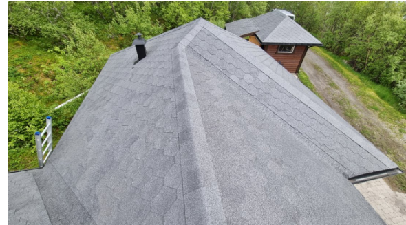
Visuell besiktelse av taket.
