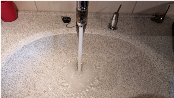
Kontroll av vanntrykk og avrenning.
