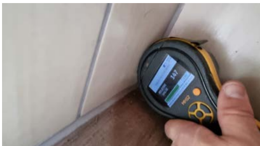
Fuktmåling i vegger, ingen unormale fuktverdier ble registrert
