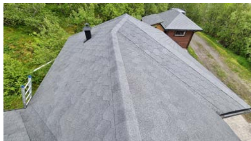
Visuell besiktelse av taket.
