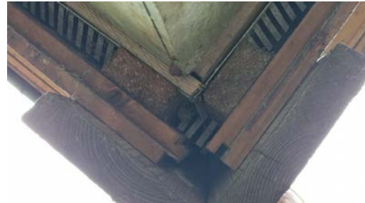
Kontroll av tetting bak ytterkledningen
