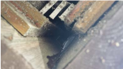
Kontroll av tetting bak ytterkledningen.
