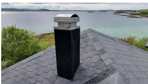
Kontroll av pipebeslag.
