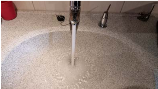
Kontroll av vanntrykk og avrenning.
