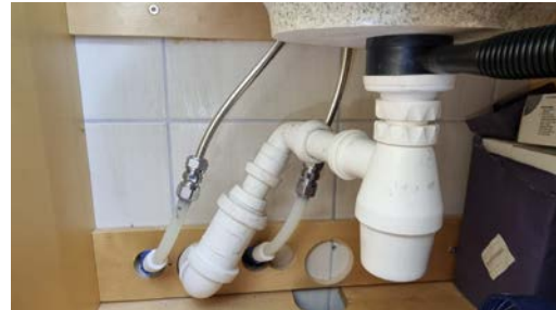
Kontroll av røropplegg under servanten.
