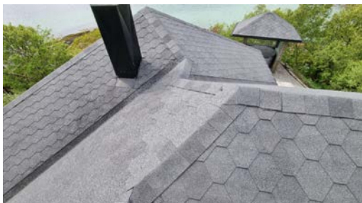
Visuell besiktelse av taket.
