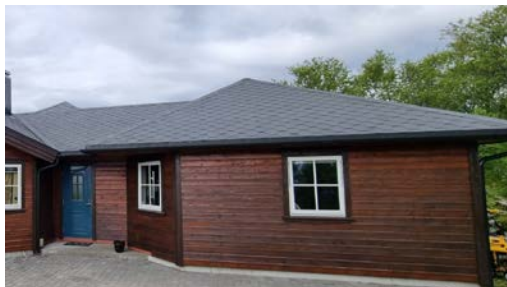
Blindloft over soveromsfløy mot øst.
