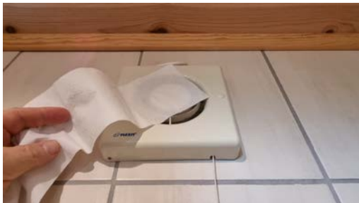
Funksjonstesting av det mekaniske avtrekket i ytterveggen.
