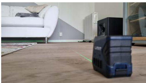
Måling av eventuelle planavvik med krysslaser. Her vist fra stue hvor største målte planavvik innenfor en diameter av 2 meter var kun ca. 1 mm, og største målte planavvik i hele rommet var kun ca. 2 mm.
