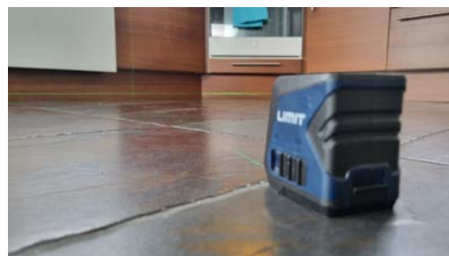
Måling av eventuelle planavvik med krysslaser. Her vist fra kjøkkenrommet inkl. spisestuen hvor største målte planavvik innenfor en diameter av 2 meter var ca. 4 mm, og største målte planavvik i hele rommet var ca. 9 mm. Også dette tilfredsstillende og mindre enn hva NS 3600 tillater av toleranseavvik.
