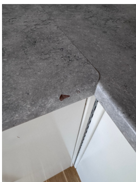
Slittasjemerke/skade på benkeplate.
