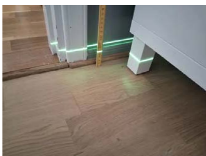
Etasjeskillet er kontrollert med nivelleringslaser.
