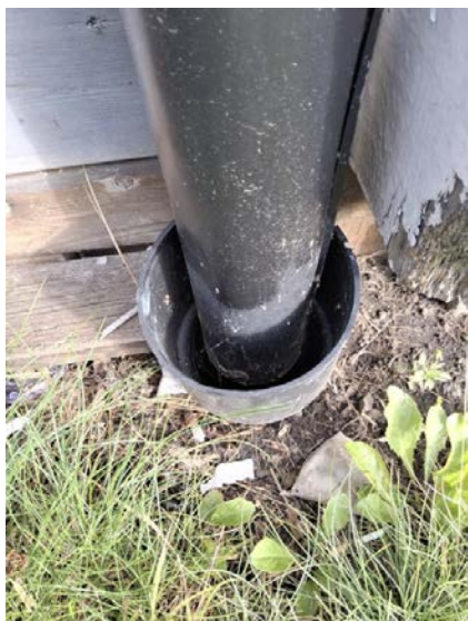
Taknedløp er ført ned i drensrør.
