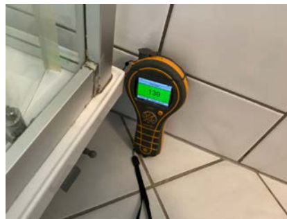
Måling ved dusjkabinett
