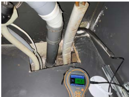
Hulltaking i kjøkkenskapet
