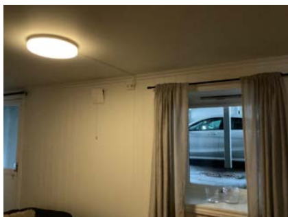
Luftventil i vegg og luftespalte i vinduet
