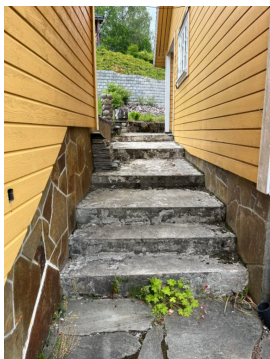
Trapp og avsatser/platting til inngangsparti.
