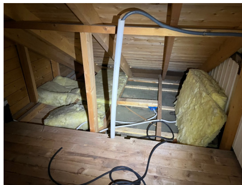
Isolasjon må legges på plass.
