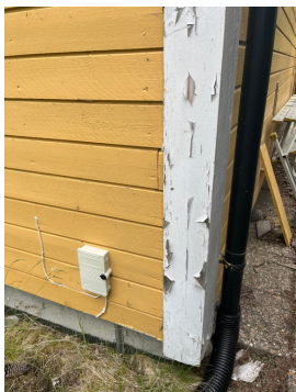
Hjørneakse med avflasket maling.
