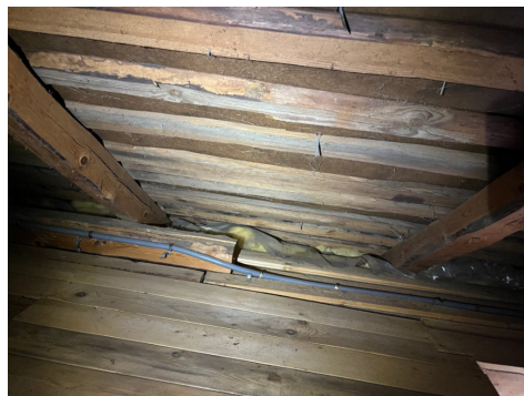
Isolasjon er lagt inntil undertaket på møneloft.
