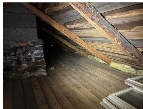
Undertaksplater på rupanel med spalter.
