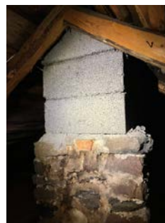
Pipe er utbedret elementer gjennom tak på mønelloft.
