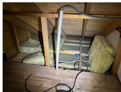
Isolasjon må legges på plass.
