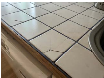
Sprekker i fliser.
