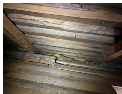
Isolasjon er lagt inntil undertaket på møneloft.
