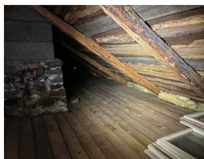
Undertaksplater på rupanel med spalter.
