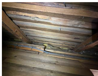
Isolasjon er lagt inntil undertaket på møneloft.
