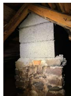
Pipe er utbedret elementer gjennom tak på møneloft.
