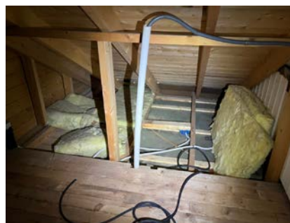
Isolasjon må legges på plass.
