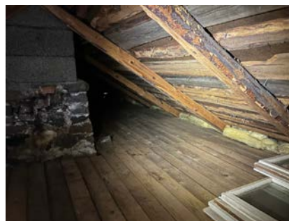
Undertaksplater på rupanel med spalter.
