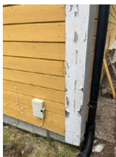
Hjørnekaske med avflasket maling.
