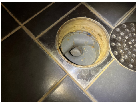
Det er ikke tettesjikt/membran ved utslagsvask.
