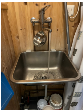
Det er ikke tettesjikt/membran ved utslagsvask.
