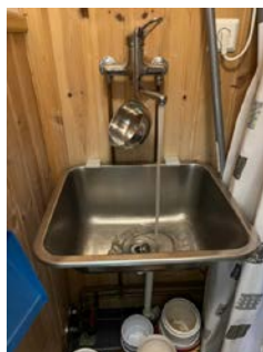
Det er ikke tettesjikt/membran ved utslagsvask.
