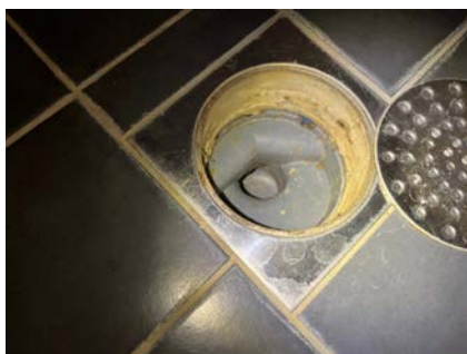
Det er ikke tettesjikt/membran ved utslagsvask.
