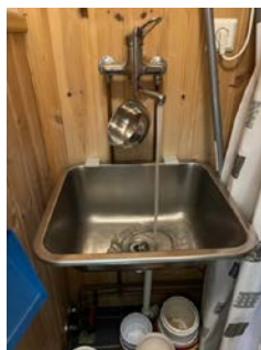
Det er ikke tettesjikt/membran ved utslagsvask.
