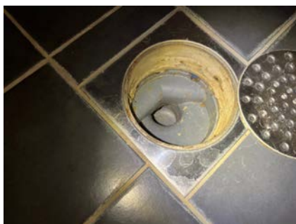
Det er ikke tettesjikt/membran ved utslagsvask.
