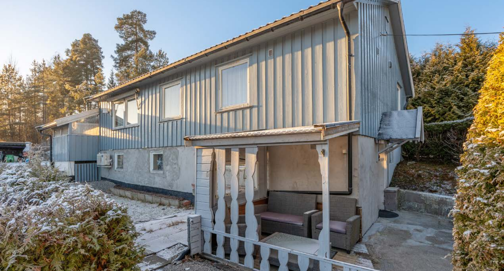
Ved inngangen til underetasjen finner man en overbygd markterrasse på rundt 6 kvm.
