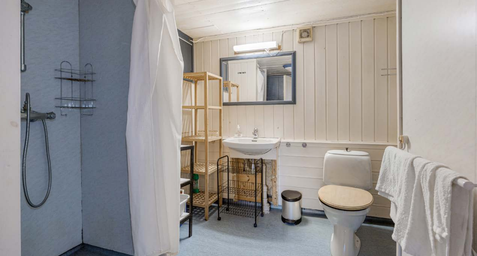
Badet i underetasjen er innredet med linoleumsbelegg på gulvet. Veggene er kledd med våtromsplater og lysmalt trepanel.
