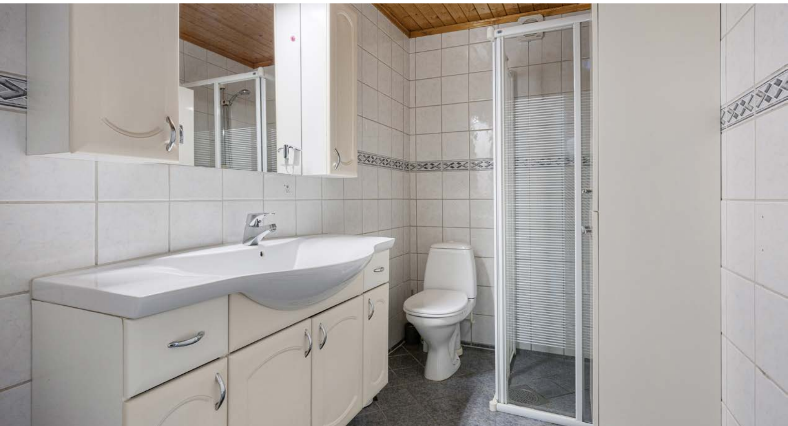
Her er det toalett, varmekabler og et dusjhjørne med skyvedører av glass.
