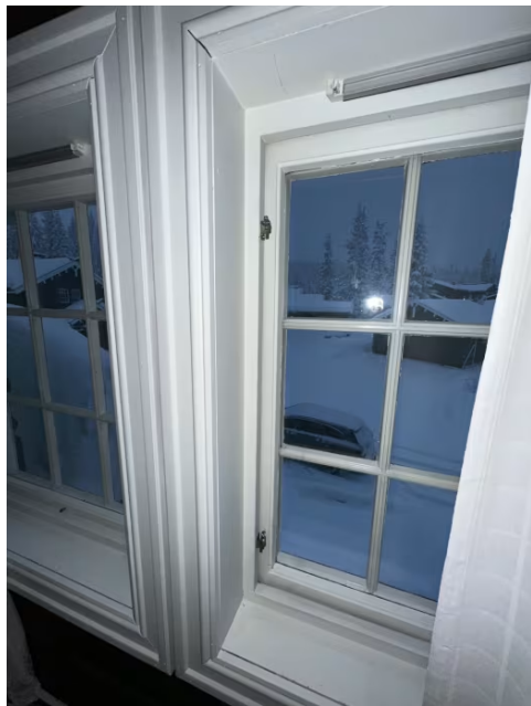
Viser eksempel på knekte vindushasper.
