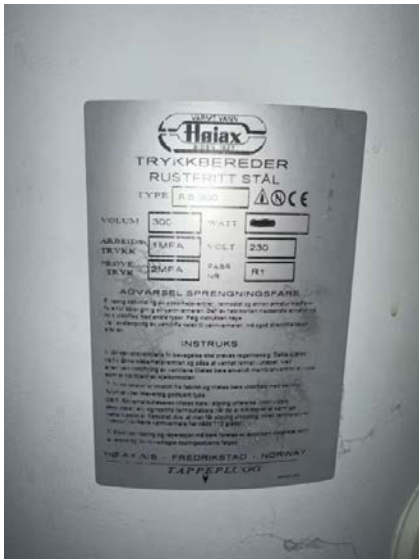
Viser teknisk data på bereder.
