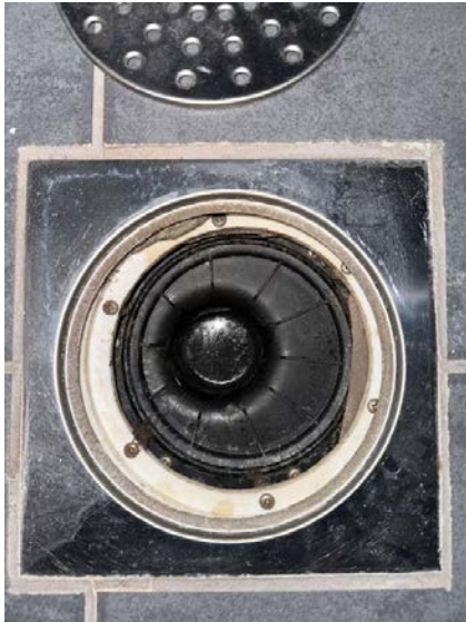
Viser sluk i dusjsonen.
