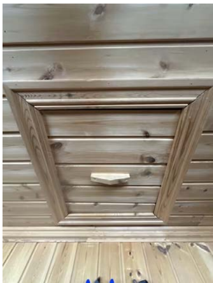
Det er etablert en luke i taket i boden for adgang til loft
