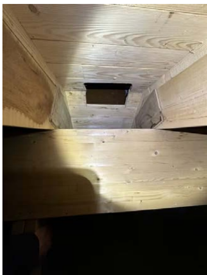
Det må utføres tiltak ved luftehett slik at snø ikke havner på kaldloft.
