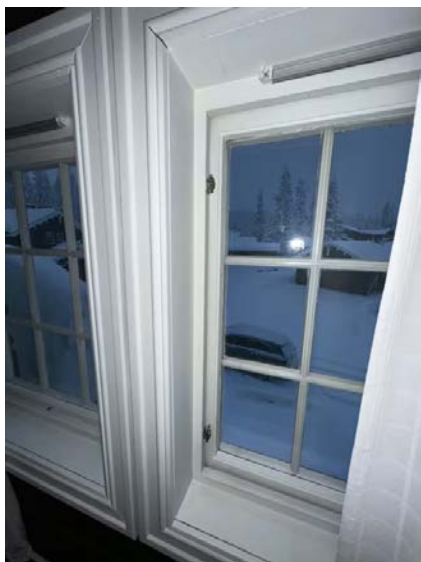
Viser eksempel på knekte vindushasper.
