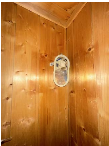
Lampe i badstue mangler skjerm. Skjerm må monteres.
