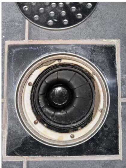
Viser sluk i dusjsonen.
