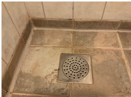
Fagmessig utførelse av silicon
