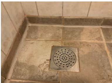
Fagmessig utførelse av silicon
