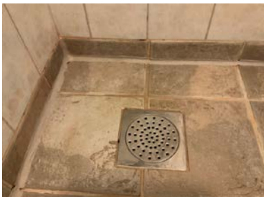
Fagmessig utførelse av silicon
