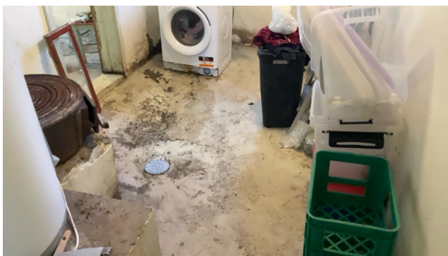
U. ETASJE > VASKEROM
