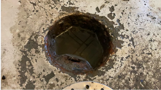
U. ETASJE > VASKEROM
