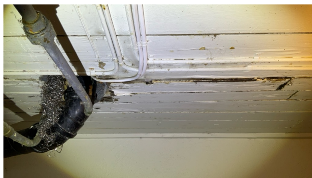
U. ETASJE > VASKEROM
