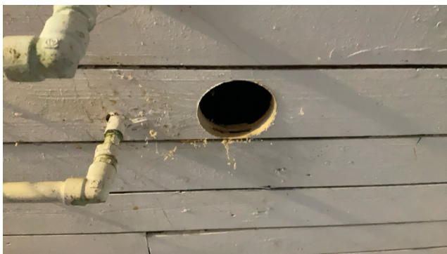
U. ETASJE > VASKEROM
