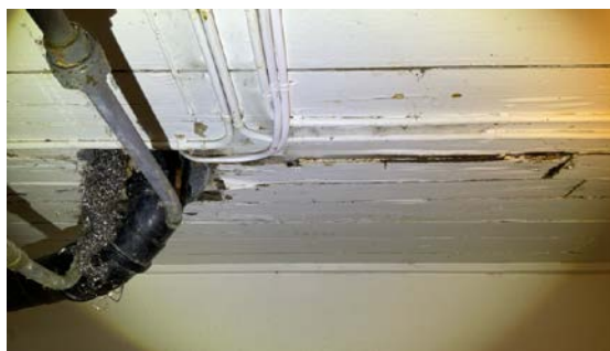
U. ETASJE > VASKEROM
