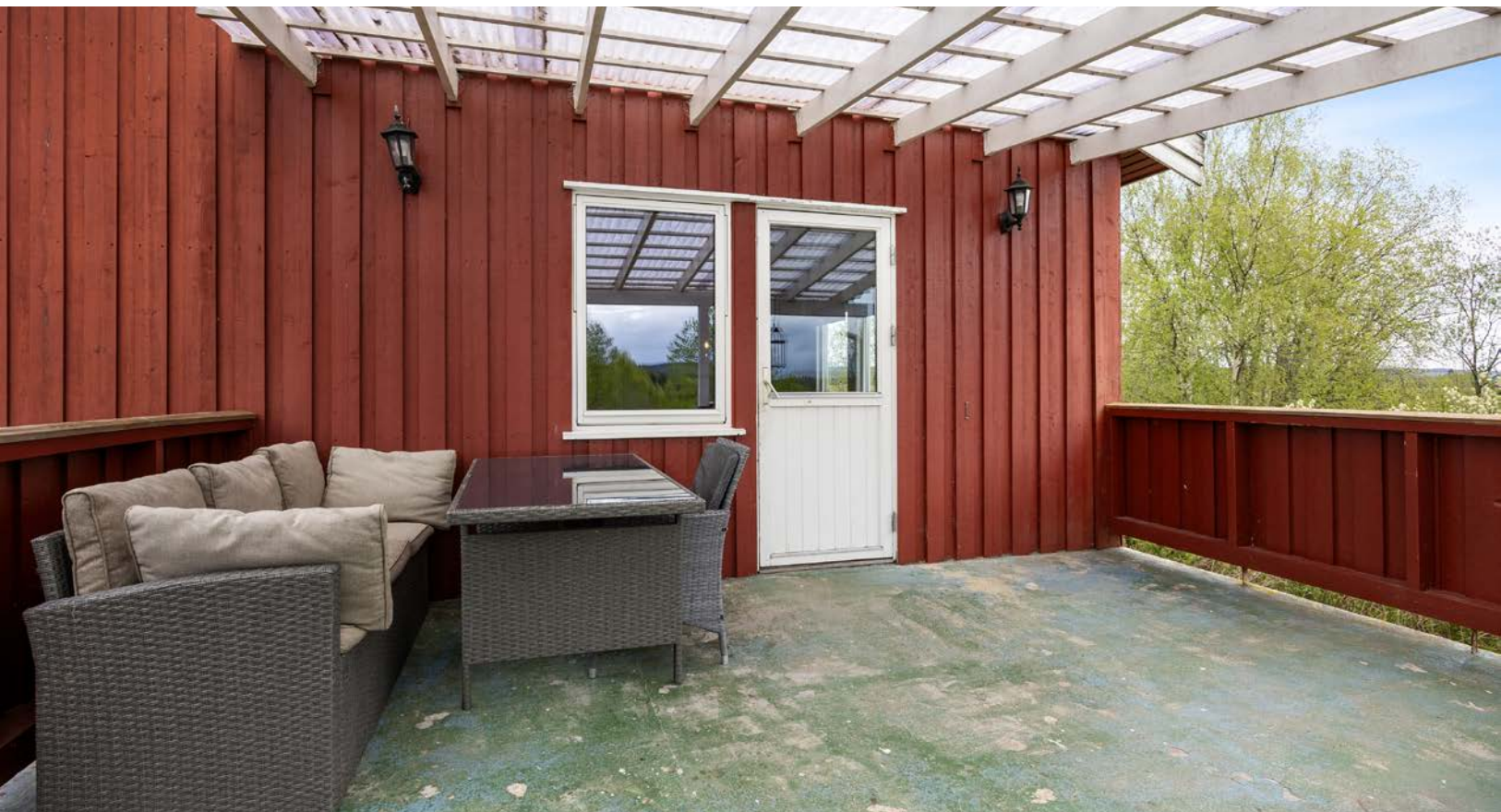
Terrasse med overbygg og plass til utemøblement.
