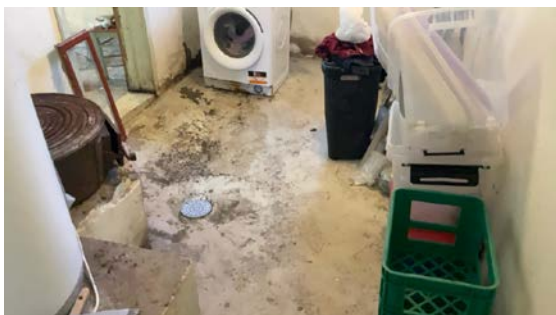
U. ETASJE > VASKEROM
