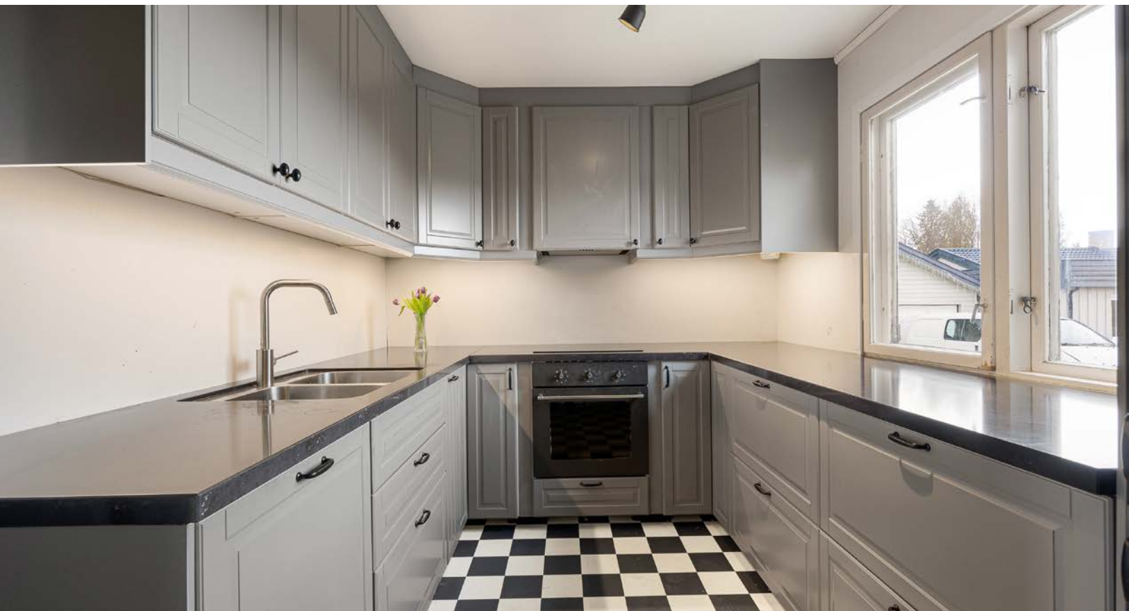
I kjøkkenet er det integrerte tilhørende hvitevarer, herunder stekeovn, platetopp, oppvaskmaskin og kjøleskap. Stekeovn har jordningsfeil og kan ikke brukes.
