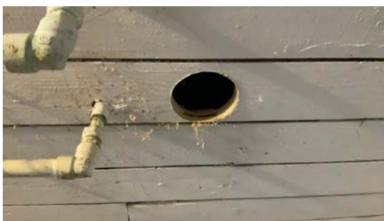
U. ETASJE > VASKEROM
