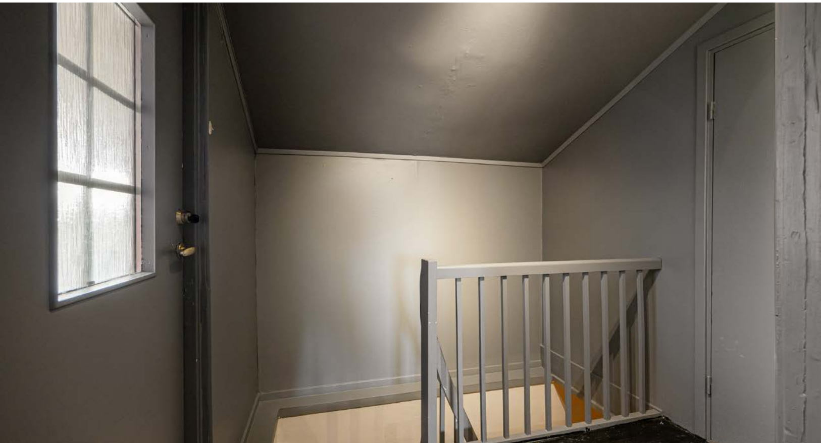
Trapp mellom 1. etasje og underetasjen.
