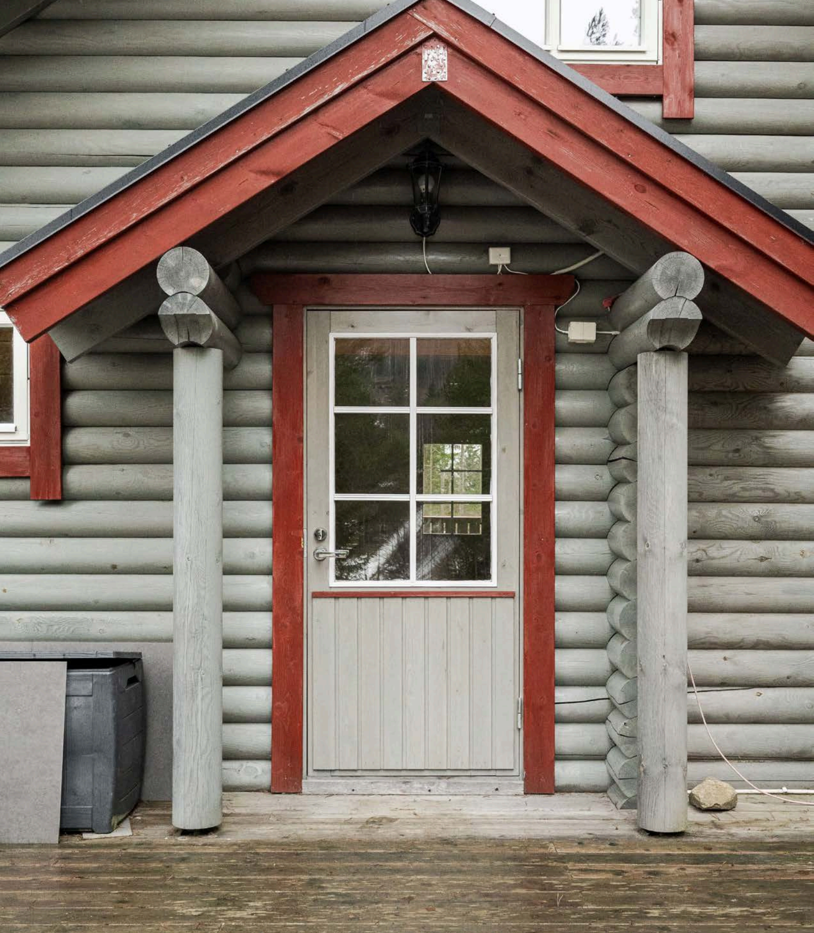
Ytterdøren har 2-lags isolerglassfelt og er beskyttet av et takoverbygg.
