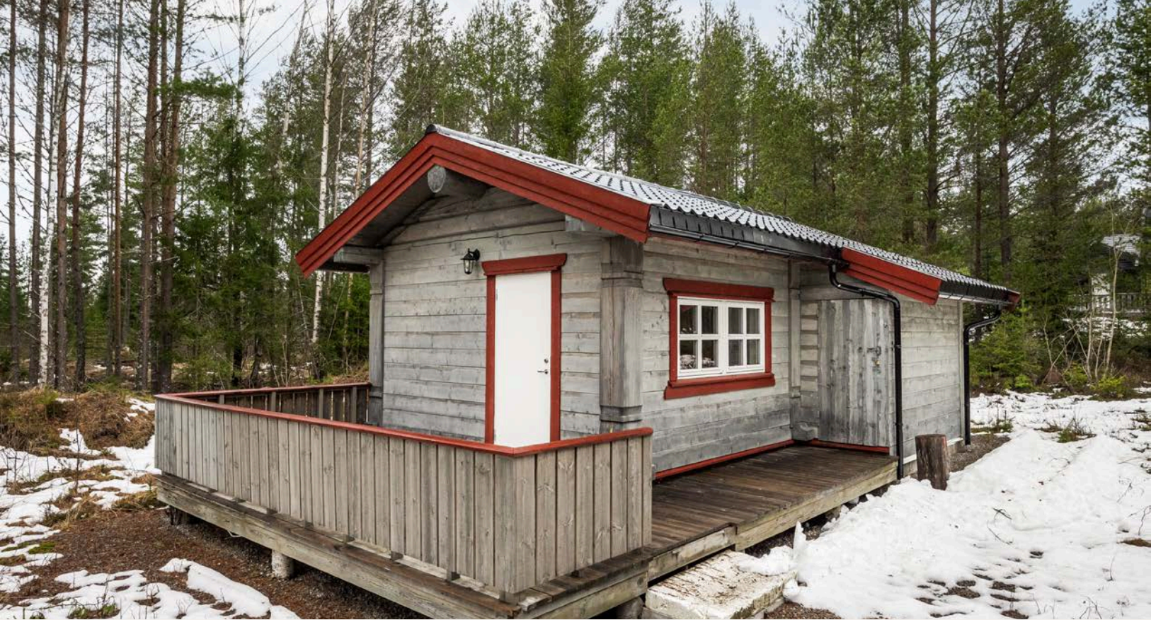
Annekset har malte trevinduer med 2-lags isolerglass og malt ytterdør.
