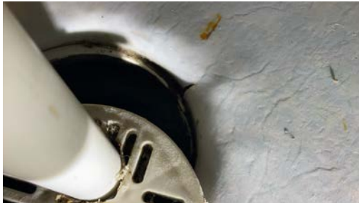
Utett belegg rundt sluk.
