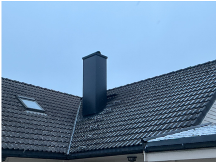
Pipe er dekket med beslag over tak.
