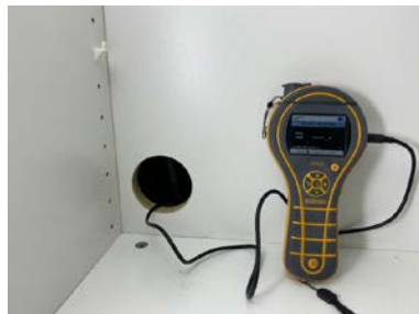
Fukt-søk i soverom.
