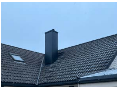
Pipe er dekket med beslag over tak.
