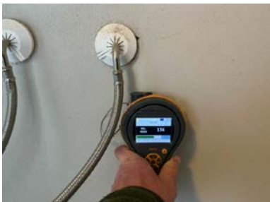
Fukt-søk på vegg bak dusj-kabinett.
