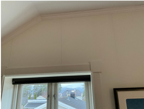
Registrert sprekker i plateskjøter, blant annet i stue.
