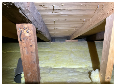
Byttet undertak på deler av takkonstruksjonen, sannsynligvis rundt 1970. Det er også tegn til at det er gjort forsterkninger av takkonstruksjonen i samme tidsrom.
