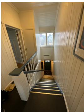
Eldre sikringskap i trapperom i boligen, eier opplyser at dette ikke er i bruk.
