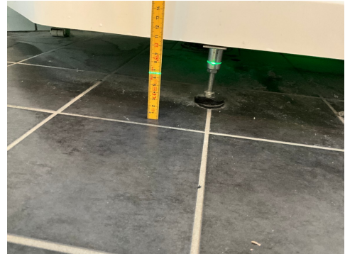
Måling av fallforhold på gulv i bad. Måling viser at gulvet er tilnærmet flatt, lokalt fall mot sluk under dusjkabinett
