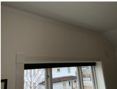
Registrert sprekker i plateskjøter, blant annet i stue.
