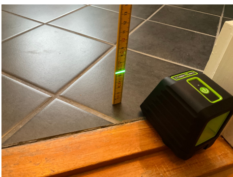
Måling av fallforhold på gulv i bad
