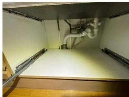
Eldre vannledninger av kobber til kjøkken.
