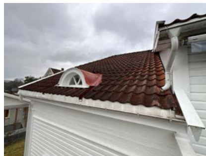
Buevindu på takflate mot vest, i stue
