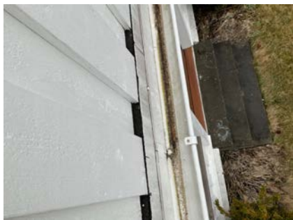
Tettesjikt av asfaltpapp
