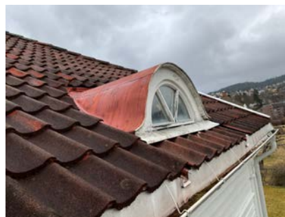
Buevindu på takflate møt øst, i soverom
