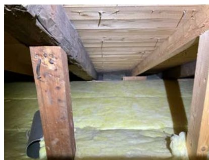
Byttet undertak på deler av takkonstruksjonen, sannsynligvis rundt 1970. Det er også tegn til at det er gjort forsterkninger av takkonstruksjonen i samme tidsrom.
