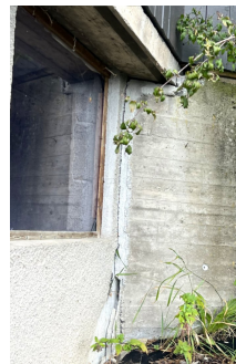
Sprekk i fm een innerdør i sokkel/kjeller.
