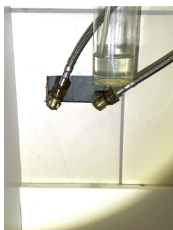
Rørgjennomføring i innredning.
