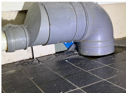
Røroppstikk under innredning.
