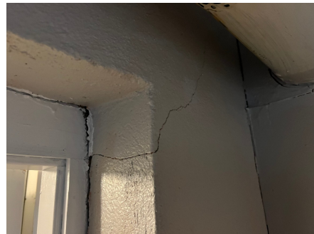
Sprekk i fm een innerdør i sokkel/kjeller.
