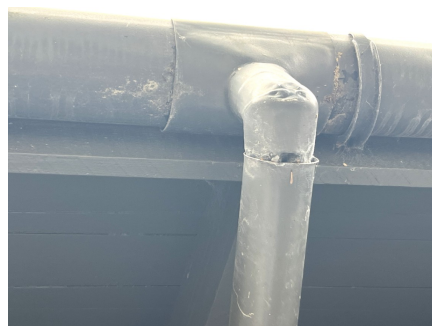
Takrenne og taknedløp.
