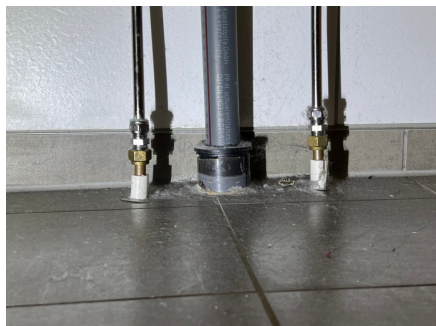
Røroppstikk under innredning.
