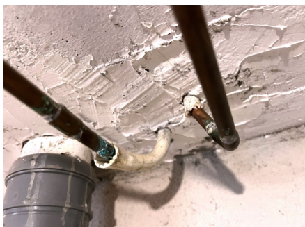
Noe irring på kobberrør.
