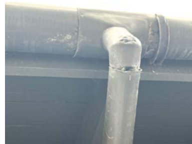
Takrenne og taknedløp.
