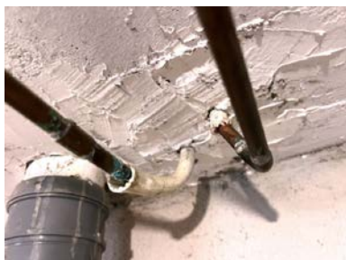
Noe irring på kobberør.
