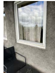
Vinduer i sokkel/kjelleruten vannbrett.
