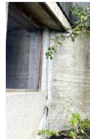
Sprekk i fm een innerdør i sokkel/kjeller.
