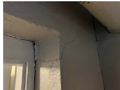
Sprekk i fm een innerdør i sokkel/kjeller.
