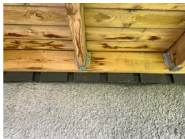
Terrasse: Bæring/Bjelke utenpå veggkledning.
