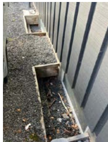
Kjellervinduer med lysbrønner nær grunnen.
