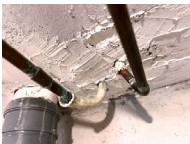
Noe irring på kobberør.
