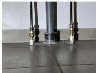
Røroppstikk under innredning.
