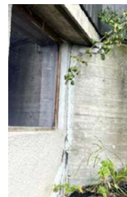
Sprekk i fm een innerdør i sokkel/kjeller.
