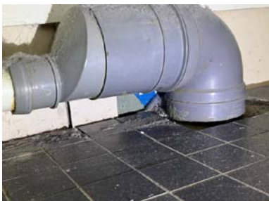
Rørøppstikk under innredning.
