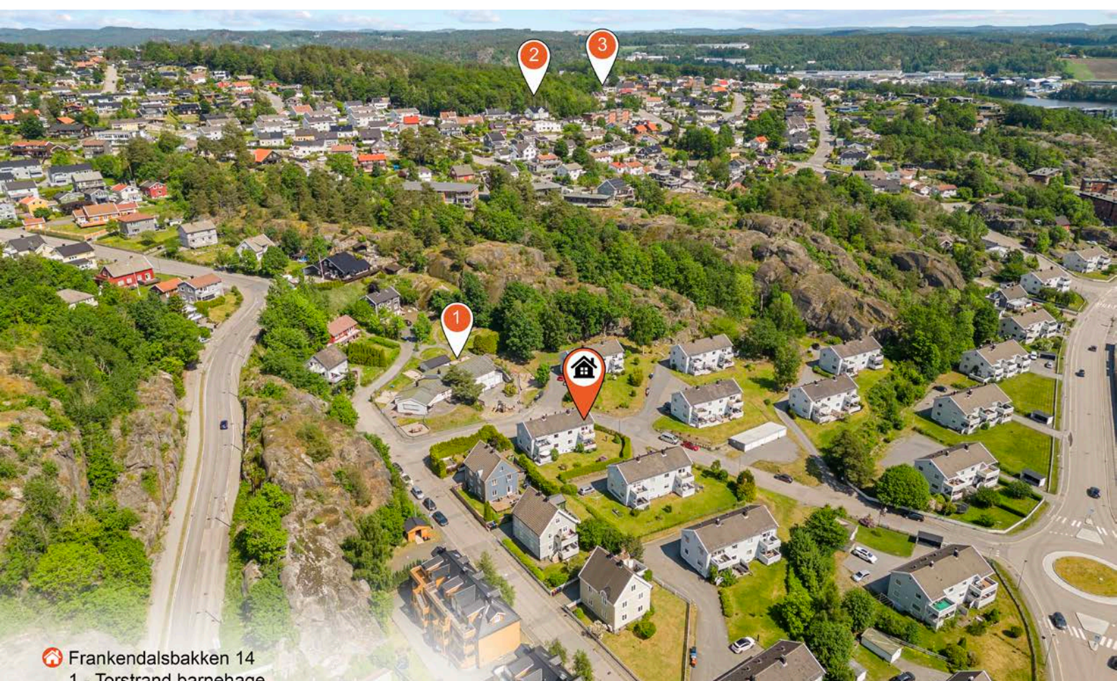
🏠 Frankendalsbakken 14 1 - Mesterfjellet skole
