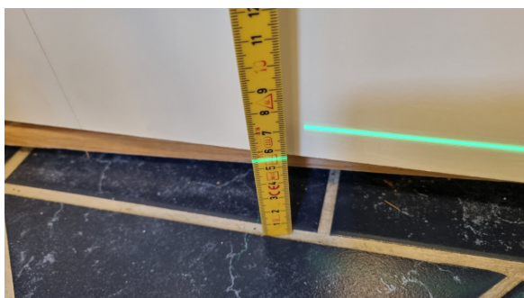
Kontroll av fall til sluk.
