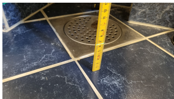
Gulvet har fall til sluk
