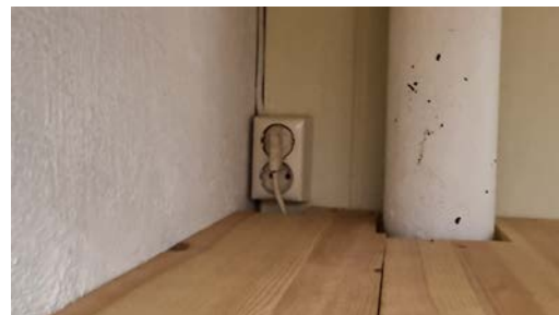
Berederen har el-tilkobling via støpsel. Dagens forskriftskrav (ref. NEK400:2014) sier at beredere over 1500 watt skal ha direkte el-tilkobling (kravet gjelder installasjoner utført etter 1. juli 2014).
