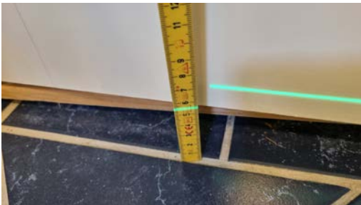
Kontroll av fall til sluk.
