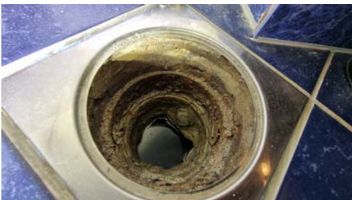
Membran i kombinasjon med gammelt sluk uten klemring. Membran er smurt ned på sluk.
