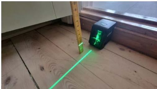
Kontroll av planavvik
