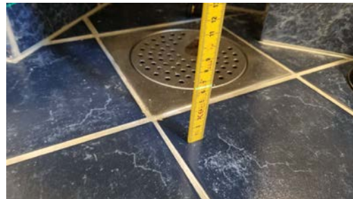
Gulvet har fall til sluk
