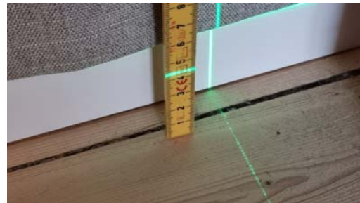
Kontroll av planavvik.
