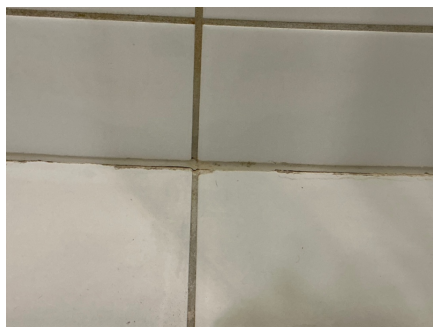
Glipe i silicon fuge mellom gulv og vegg,
