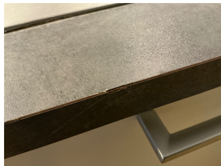
Skade på benkeplate vurderes som normal slitasje.
