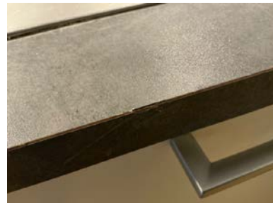
Skade på benkeplate vurderes som normal slitasje.
