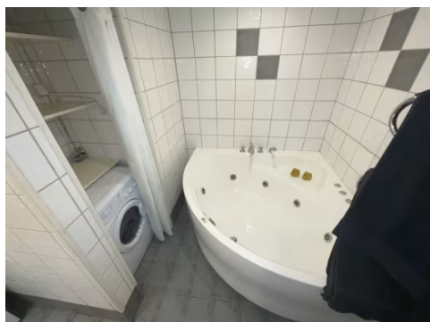
Viser boblebad og opplegg for vaskemaskin.
