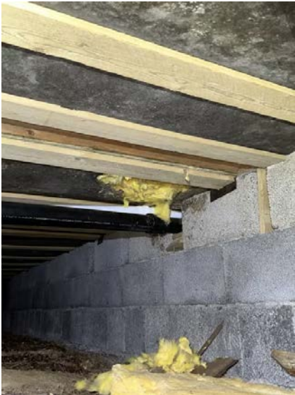
Viser skader på plate, isolasjon og bjelkelag er eksponert.
