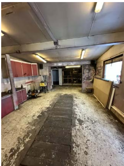
Viser deler av garasje innvendig.
