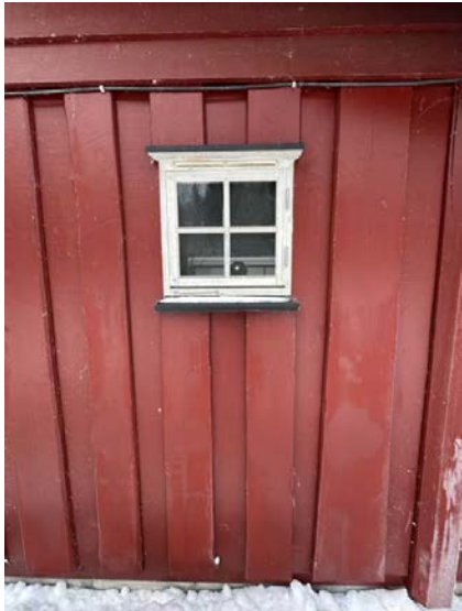
Viser vindu på bad som er kledd igjen på innsiden.
