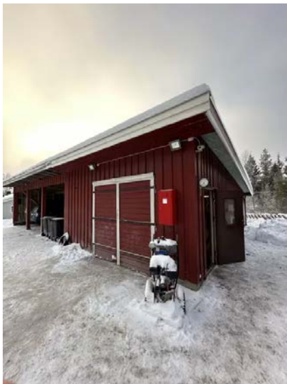
Viser garasje. Opplyst at carport tilhører nabo.
