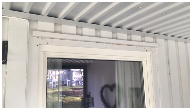
skjevheter på belistning
