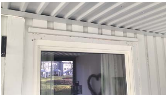
skjevhet på belasting
