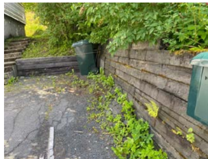
Forstøtningsmur mot sør.
