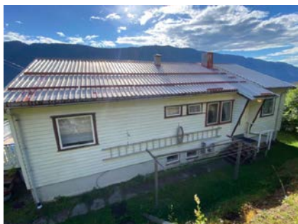
Takteking sett fra øst.
