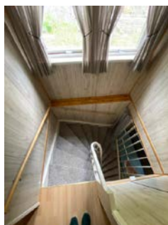
Trapp fra hovedetasje til underetasjen.
