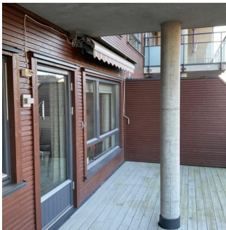
Markterrasse, overliggende støpt dekke med balkong
