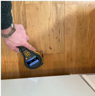
Måling med Protimeter angir normale fuktverdier på gulv foran kjøkkenbenk / oppvaskmaskin.
