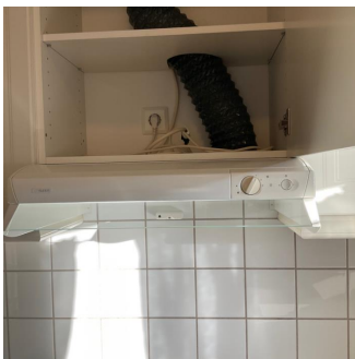
Flexit boligventilasjon _ kjøkkenventilator
