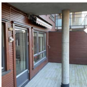
Markterrasse, overliggende støpt dekke med balkong
