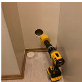
Tilstøtende vegg i bod mot våtsone på badet
