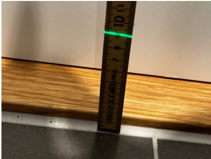
Fallforhold ca. 90 mm overkant gulv ved terskel
