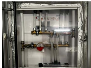
Vannforderskap rør-i-rør system
