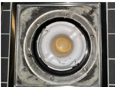
Plastsluk med klemring og synlig membran/mansjett
